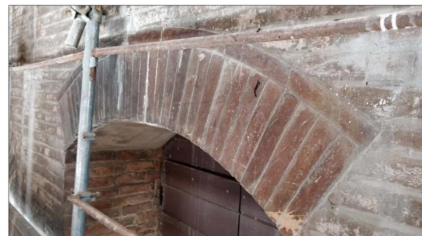
FOTO 1 - ARCO DI SCARICO SU APERTURA ESISTENTE
