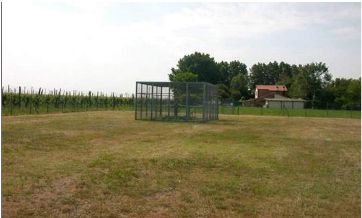
Figura B.2.2: Esempio di postazione ripristinata in attesa dell'avvio di procedura di V.I.A. (area recintata e gabbia metallica a protezione della testa pozzo)
