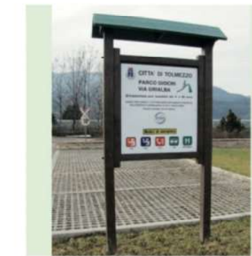
Fornitura e posa in opera di tabella informativa cm. 125x125 su pali di ferro tubolare, compreso getto per fondazione.
