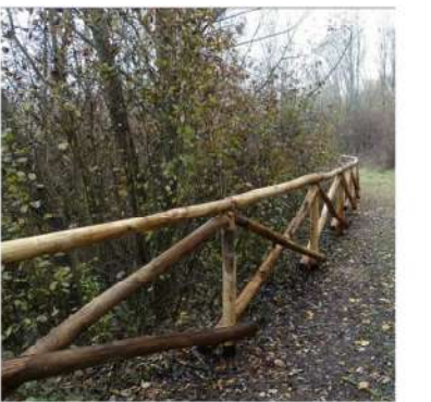
Siaconata in legname di castagno costruita con pali incrociati trattati, assemblate con apposite staffe in acciaio.
