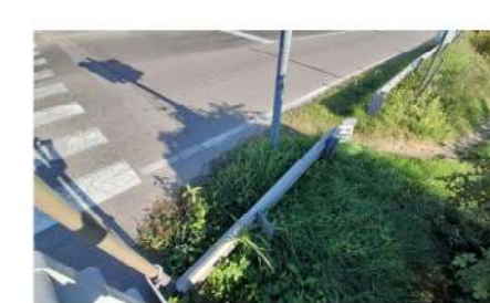
INGR. ATTUALE PONTE ROSSO
