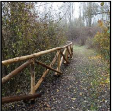
Staccionata in legname di castagno costruita con pali incrociati trattati, assemblate con apposite staffe in acciaio.
