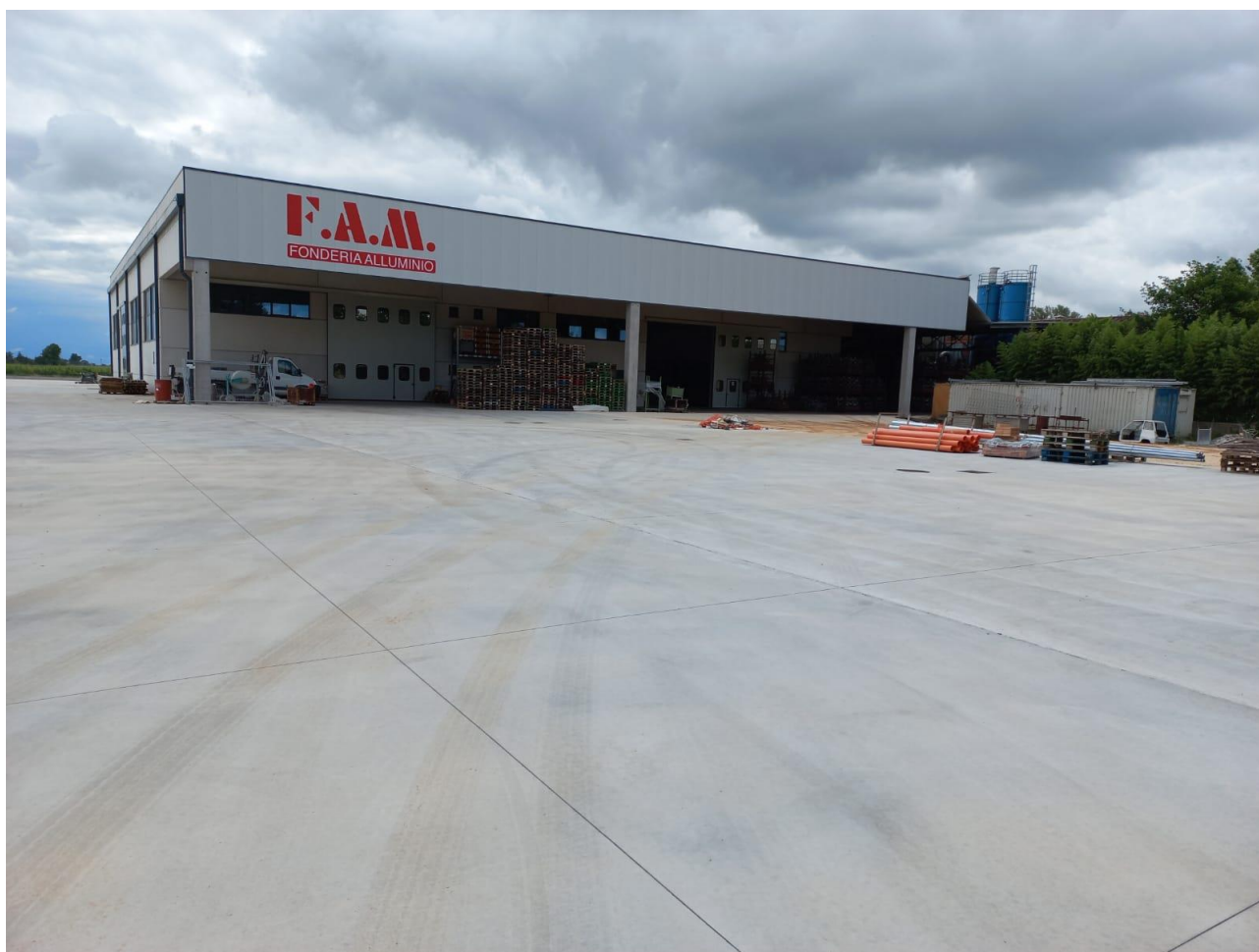
Figura D-3: Nuovo capannone realizzato
