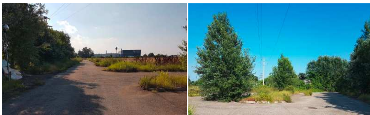
Scatti fotografici acquisiti sull'area, rappresentativi della presenza delle urbanizzazioni già attuate e citate nel testo
