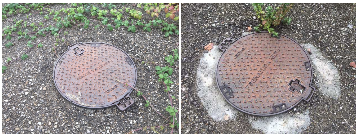
Tombini relativi alle due linee fognarie, bianca e nera, già realizzate
