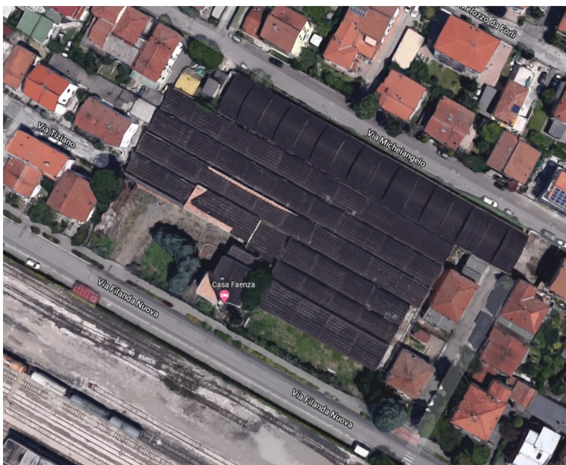
Situazione precedente la demolizione
