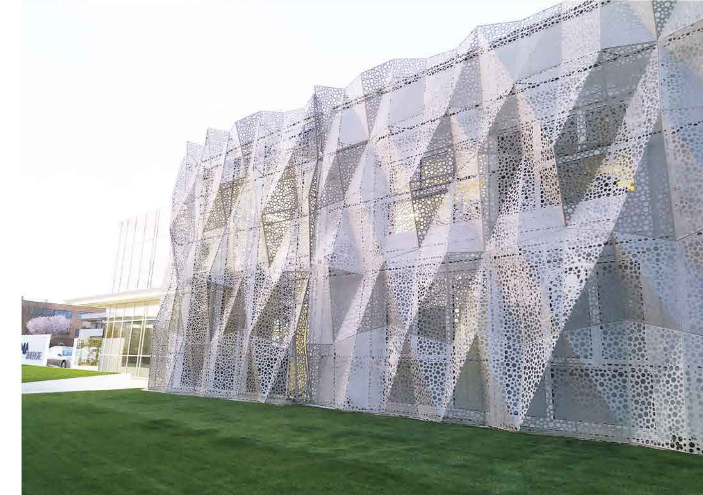
11. Prospetto sud-ovest di Tema 4 e sistema ombreggiante di facciata.
