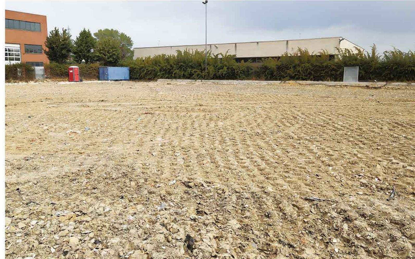
16. Demolizione della provincia e costipamento del terreno: sedime del futuro ampliamento T6.
