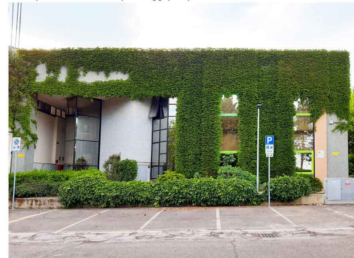
2. Corpo di fabbrica T1 e parcheggi prospicienti.
