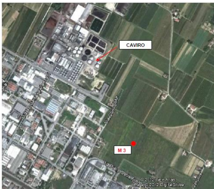
Figura 4: Localizzazione postazione spot per la verifica degli indotti Caviro.
