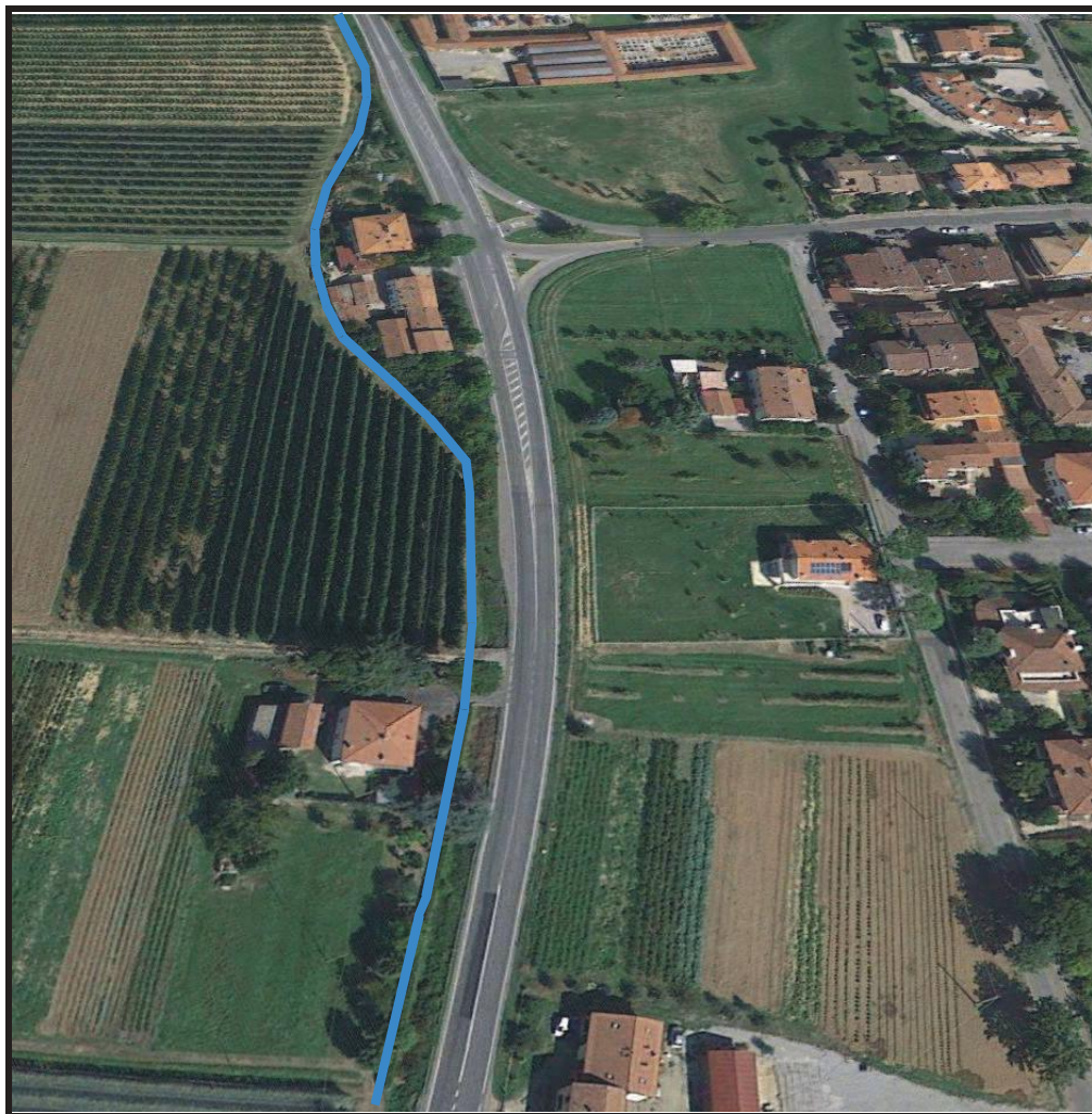
Foto 1: Fosso di scolo via Casolana verso Nord-Est
