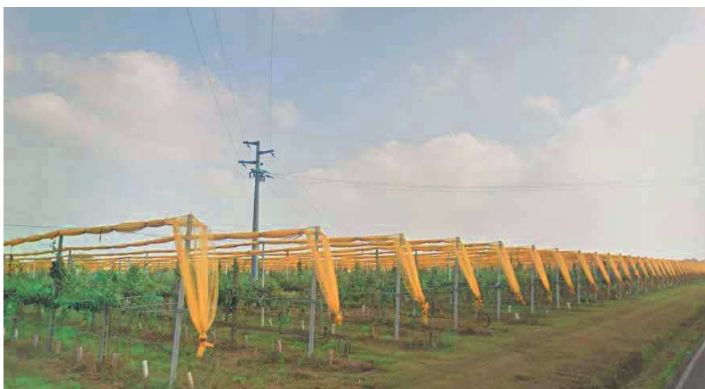
Traliccio della linea MT, in prossimità di via S.Orsola: si tratta della linea che interessa anche la porzione edificabile d'ambito
