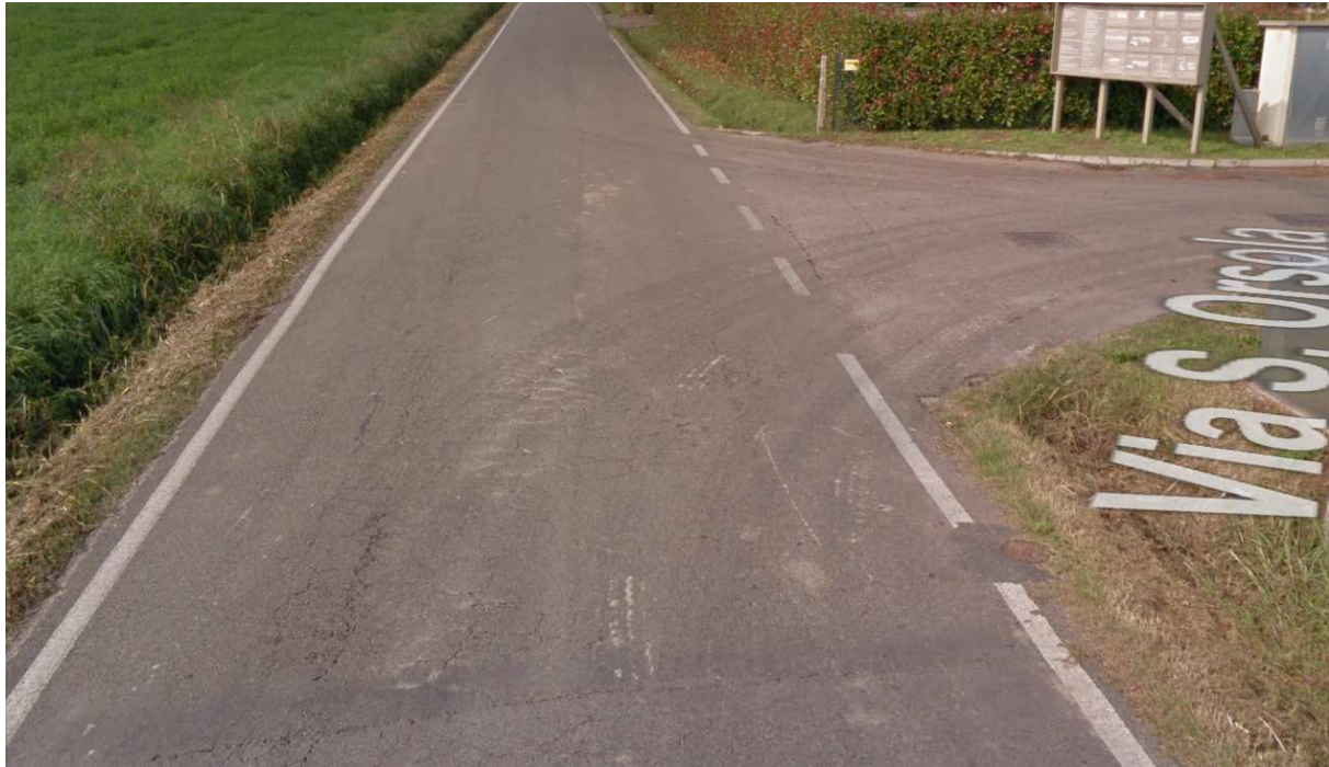
Condizioni dell'asfalto attuale
