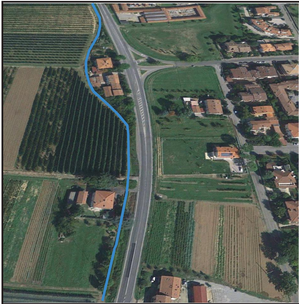
Foto 1: Fosso di scolo via Casolana verso Nord-Est
