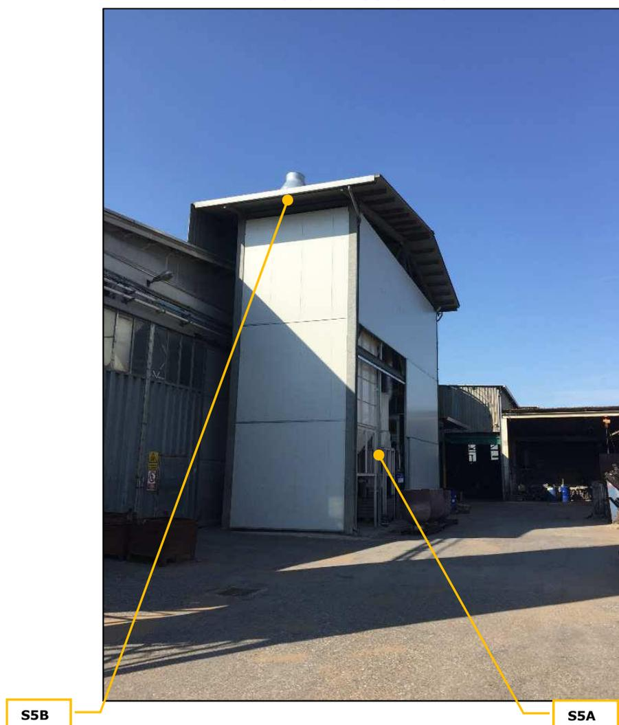
Durante il sopralluogo è stato possibile eseguire un rilievo al confine di proprietà di fronte all'impianto in esame, al fine di caratterizzare tutte le sorgenti sonore raggruppate con la sigla S5A. Per quanto riguarda il camino (S5B), dato che non è stato possibile eseguire il rilievo fonometrico alla sorgente sonora, si riporta il calcolo previsionale come descritto all'interno del documento precedentemente citato.
