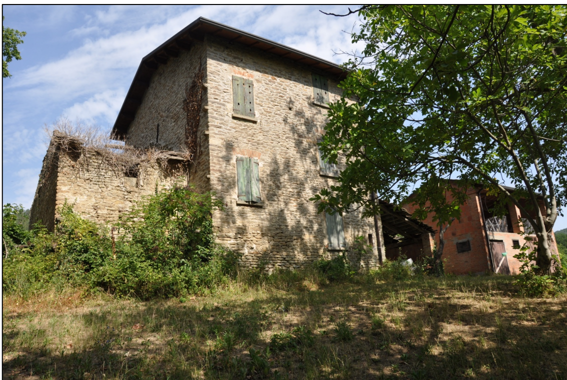
Foto degli edifici esistenti che saranno oggetto di demolizione
